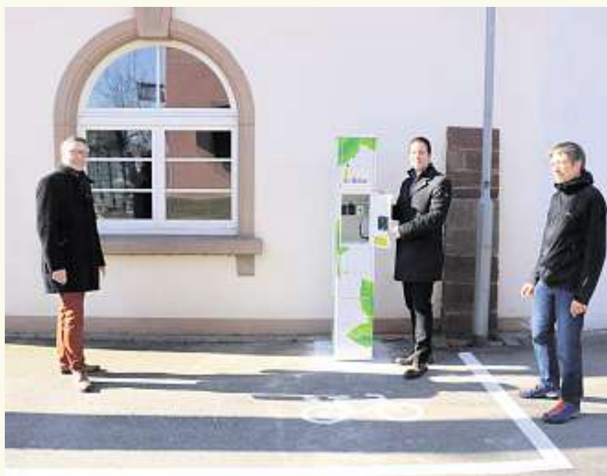
Stefan Müller (Überlandwerk Mittelbaden), Bürgermeister Manuel Tabor und Stephan Huber vom Bauamt vor der neuen Ladestation (v.l.)
