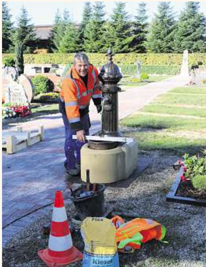
Wassermeister Thomas Sauer bei der Installation des neuen Brunnens
