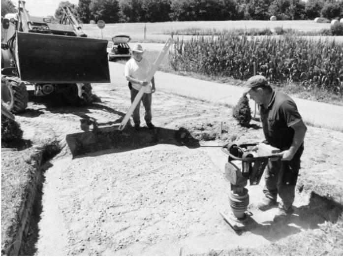
Zunächst wurde mit der Vorbereitung der Platzgestaltung an den einzelnen Raststationen begonnen. Der Boden für die Sitzelemente wurde mit einem Bagger ordentlich begradigt und ein solider Unterbau für die Pflasterfläche geschaffen. Im Anschluss haben engagierte Helfer des Vereins, angeführt von Thomas Sauer und Frank Köhli, die Flächen gepflastert.
