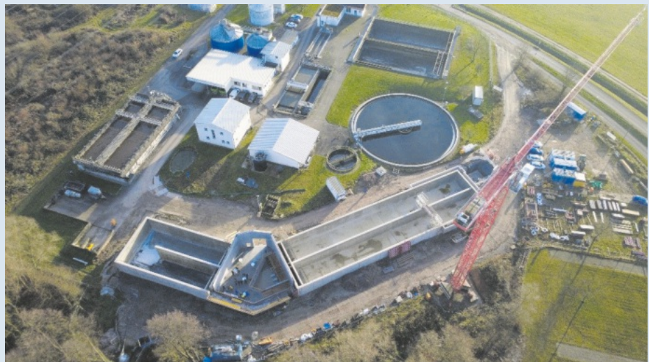
Der Erweiterungsbau der Kläranlage nimmt Schritt für Schritt Form an.
